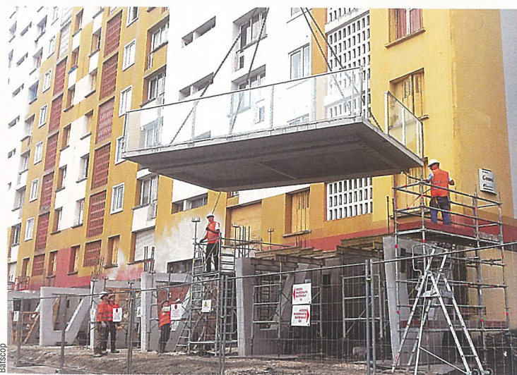
Levage d'une dalle du jardin d'hiver, équipée du garde-corps du balcon..
