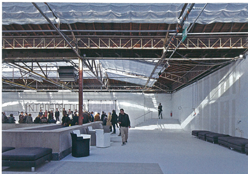
Below: Lacaton & Vassal, Palais de Tokyo, 2012, Paris. Photo: Philippe Ruault.
