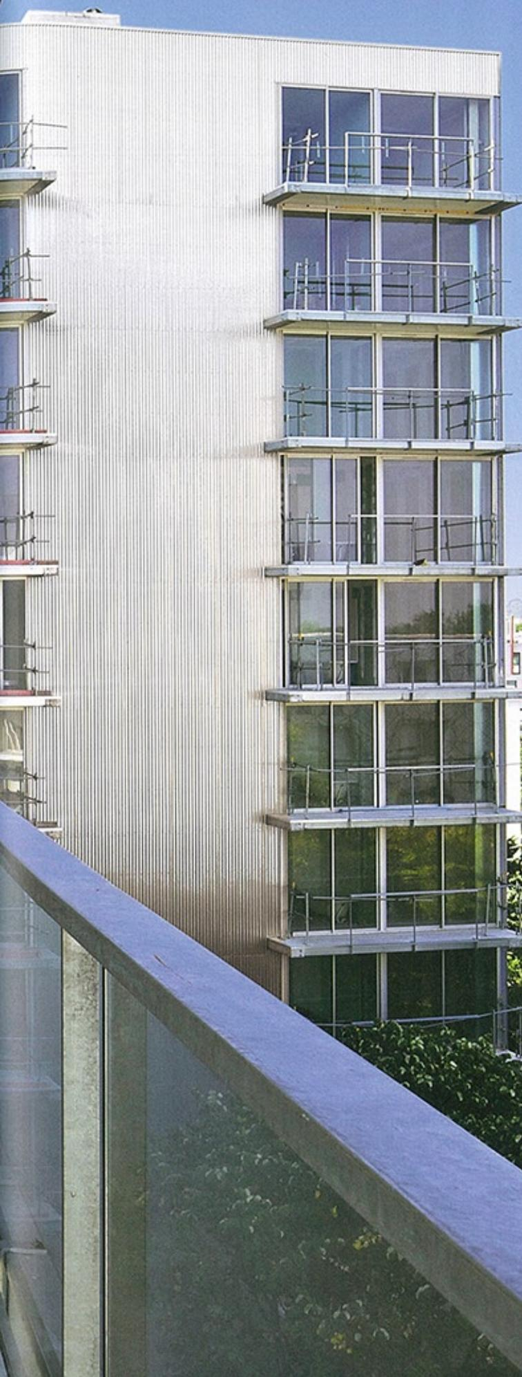
Bewusst einfache Bauweise aus Metallträgern und Betonfertigböden, große Aufwertung der Wohnungen durch mehr Licht und Freiraum. Deliberately simple construction method made of metal beams and precast concrete floors, enormous added value to the apartments due to more light and free space.
