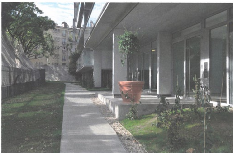
Tour Bois le Prêtre i Paris 17. arr. Transformation af et 1970'ers-projekt som stod til nedrivning. Før og efter. Foto: Lacaton & Vassal.
