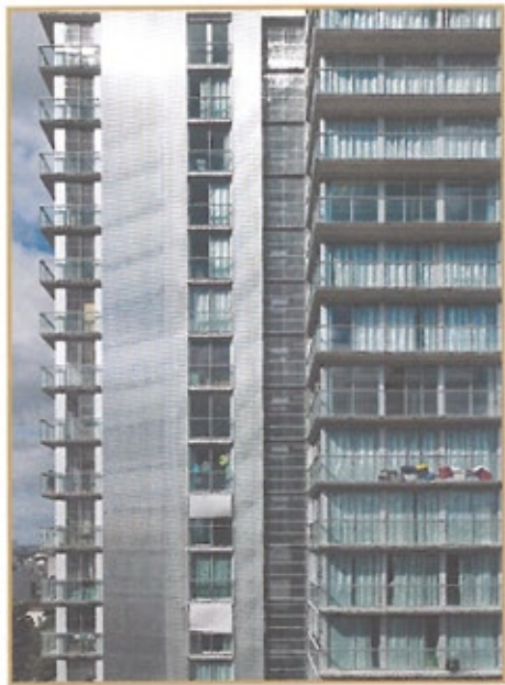
1 et 2. Vue générale de la tour et détail de la façade est. Ph. © David Boureau.
