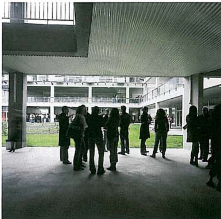
Utilisée comme dispositif lumineux, la tôle d'aluminium ondulée permet d'attirer la lumière naturelle jusqu'au cœur d'îlot.
